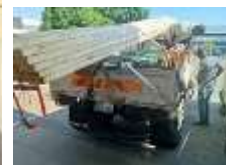
ボンドイア村 小学校・寄宿舎 修繕
